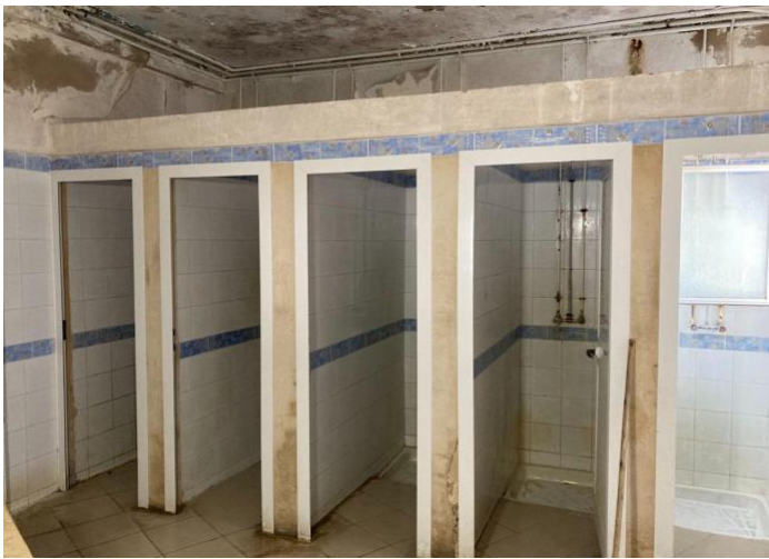
Photo 5 : Sanitaires du centre de La Marsa, le 9 mai 2022
